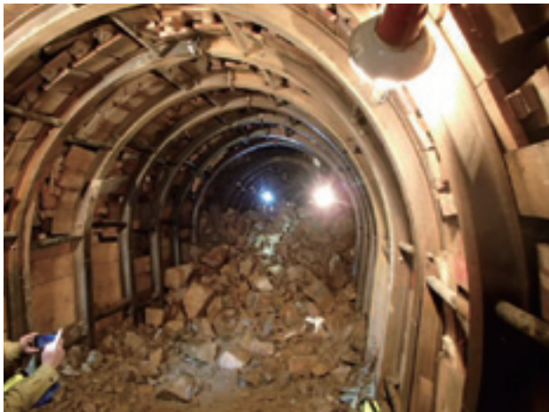
▲導水路トンネル貫通状況
