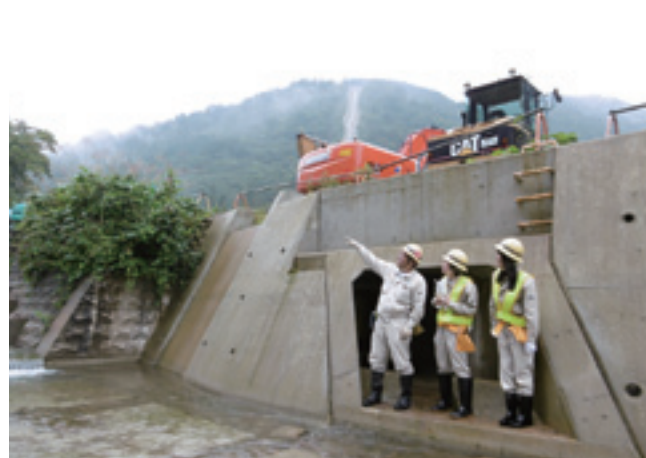
▲水力発電所の終点・放水口
