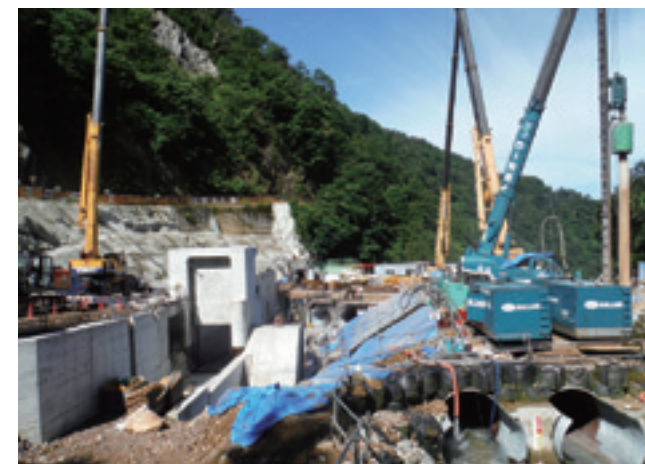
▲取水堰・取水ゲート
