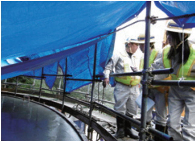
▲打ち終わったばかりのコンクリート
