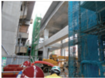
信越線高架化笹口工区2
