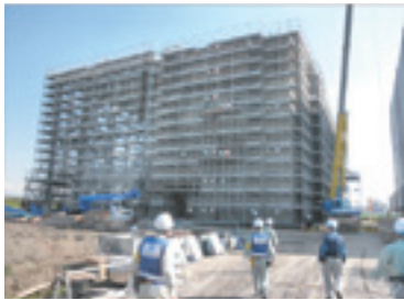
二上浄化センター建設工事
