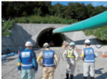
天神堂トンネル工事
