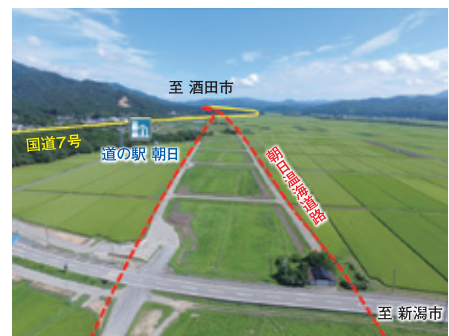
国道7号 朝日温海道路の工事着手
