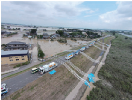
排水ポンプ車による排水作業（関東東北豪雨）
