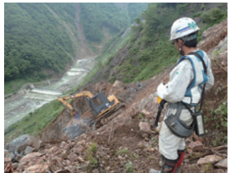
無人化施工機械による施工
