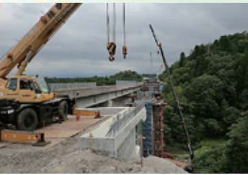
上信越自動車道 金谷工事
