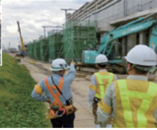
富山高架西BL新設他2工事
