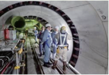
大石排水区大石2号貯留管下水道工事
