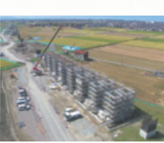
能美西任田高架工事
