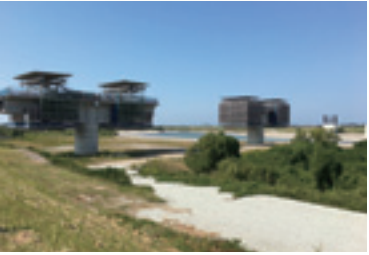
手取川橋りょう他工事
