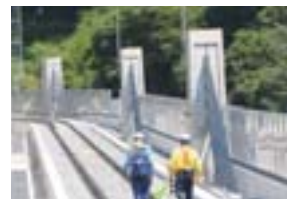
エクストラードスド橋の斜材ケーブル
