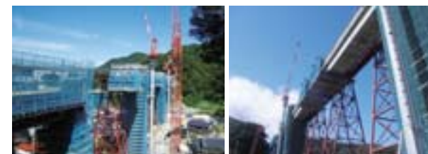
旧鉄橋と新橋梁が並ぶ工事中の風景
