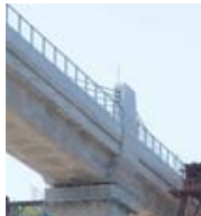
電車内からの眺めや、景観に配慮された防風壁
