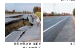
常磐自動車道 復旧前(東日本大震災)
