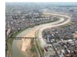
阪神高速大和川線工事
