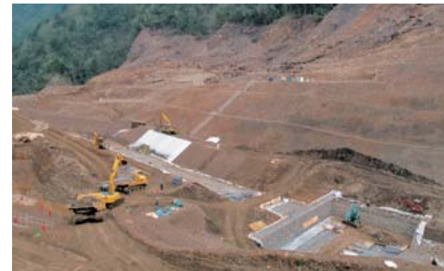
紀伊半島大水害復旧工事(赤谷)
