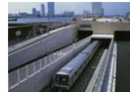
大阪咲洲トンネル
