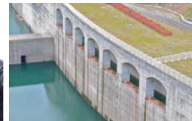
カスケード(計画水位維持放流設備)
