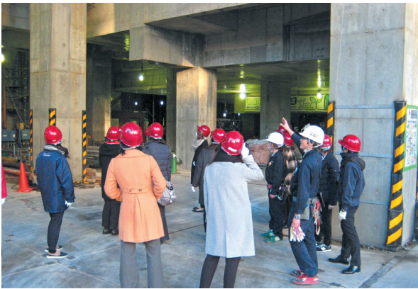
御園座共同ビル新築工事
