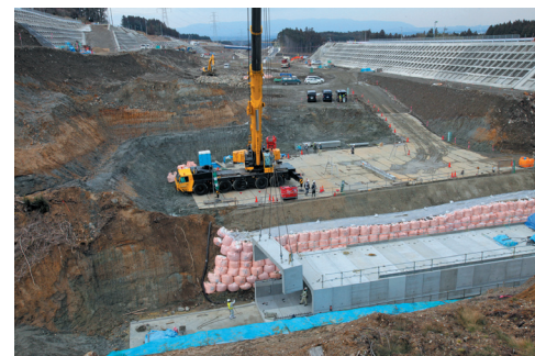
700mにわたる河川付け替え工事。220トンクレーンでボックスカルバートを設置
