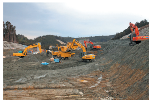
6割ほど掘削工事が進んだ切土場
