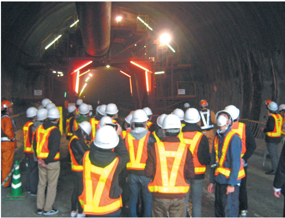
新名神四日市西トンネル工事(平成28年11月8日)
