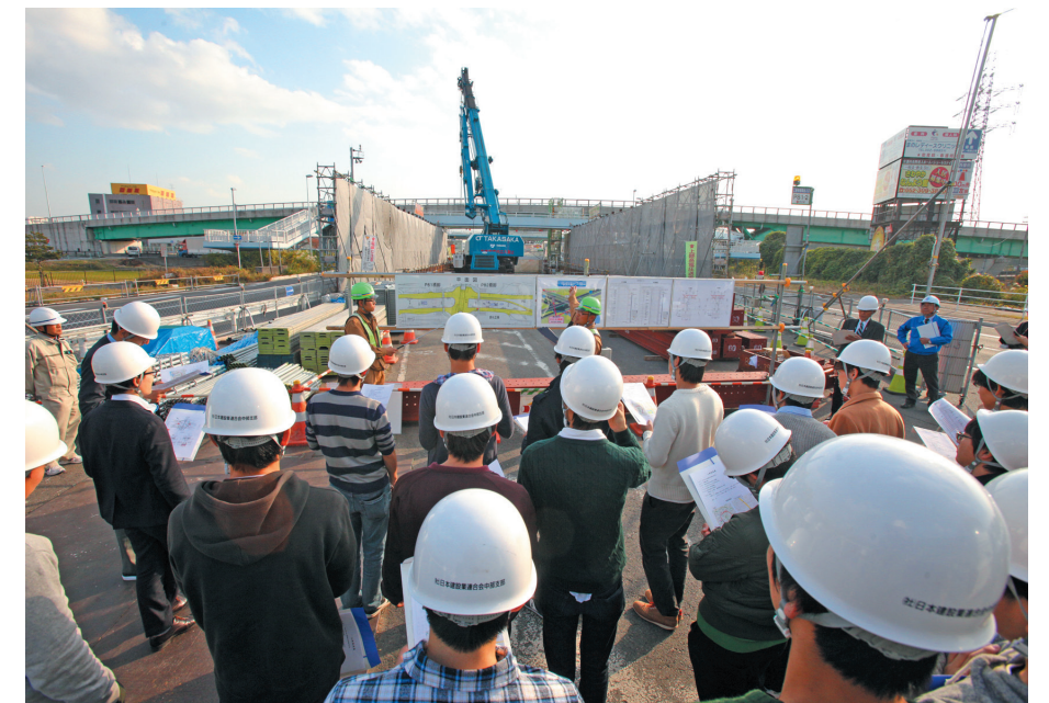
高架橋工事の規模の大きさを体感する
