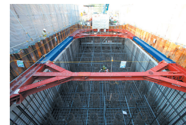
橋脚の基礎工事が進む
