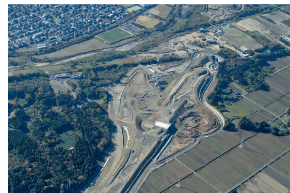
上空から見た建設中の菰野IC(仮称)(平成28年12月撮影)
