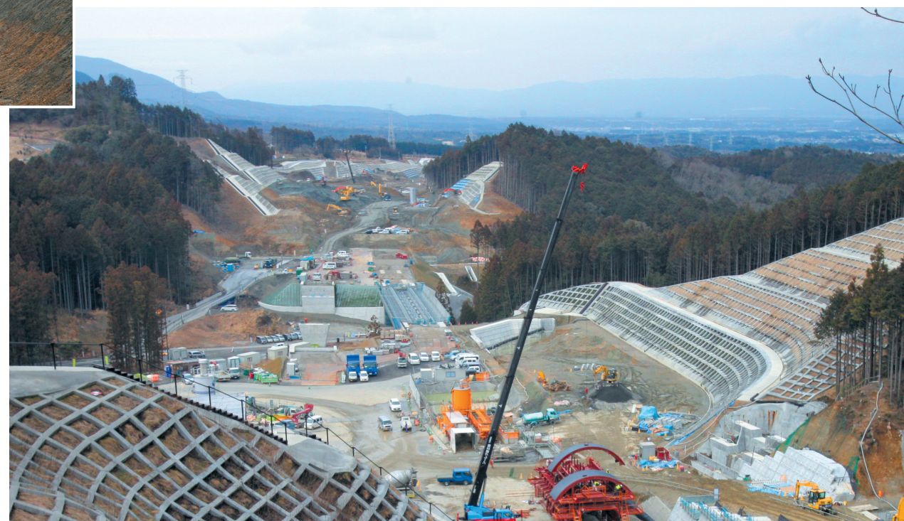
工事終点側からの全景
