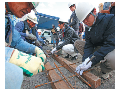
現場の作業員から鉄筋結束の指導を受ける
