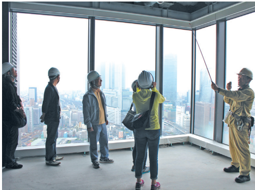
ささしまライブ24グローバルゲート新築工事
