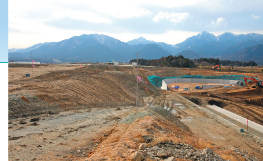
菰野IC(仮称)建設中のインター盛土場と調整池の造成
