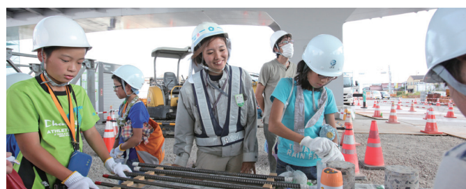
工事で使用する鉄筋などの説明
