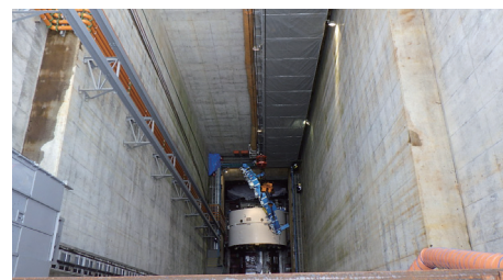
押切公園の立坑からシールドマシンを分割して投入
