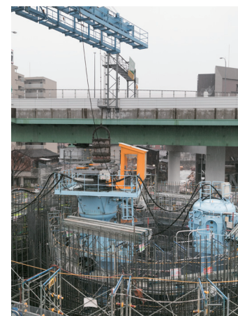
排土設備のABキャリアを使って作業室の土砂を地上へ運び出す
