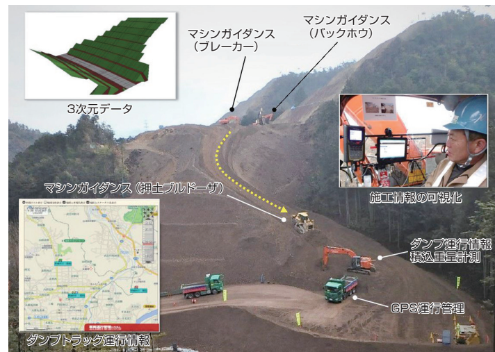
東海環状自動車道広見地区西道路建設工事
