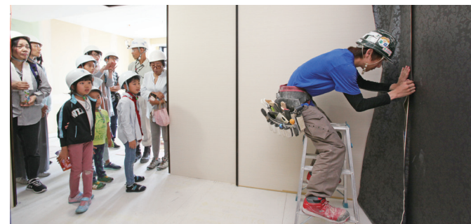
柄の継ぎ目を合わせるクロス貼りの職人技を見学
