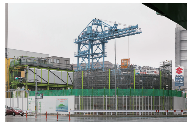
山王橋交差点から見た工事現場
