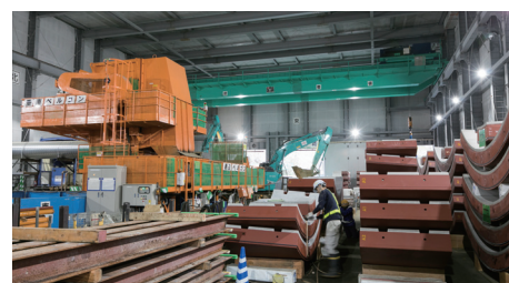
防音ハウス内でセグメント搬入と土砂搬出が行われる
