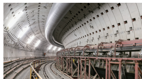
天神山交差点付近、トンネルは大きくカーブする
