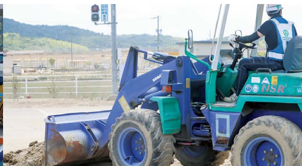
道路啓開作業(写真提供: 中国地方整備局)
