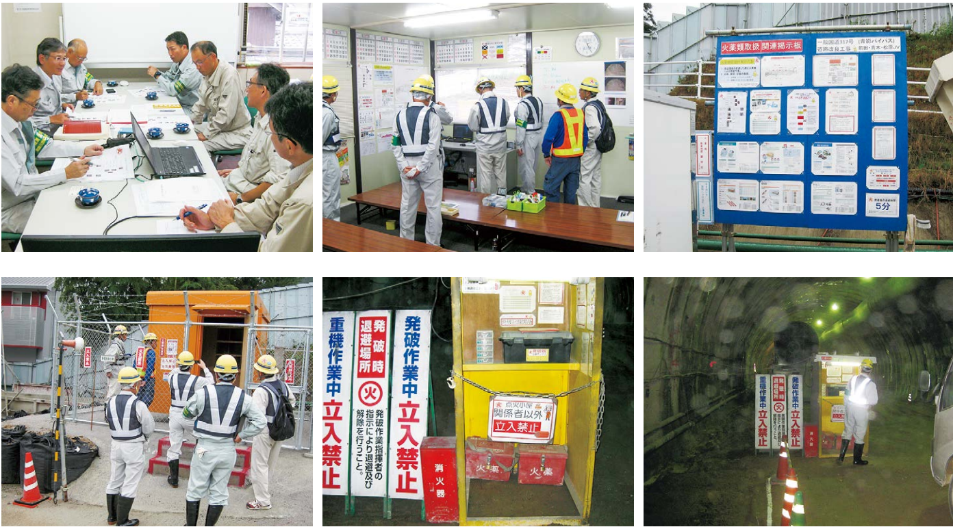
新青影トンネル点検
