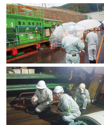
高速5号線NATMトンネル工事環境点検
