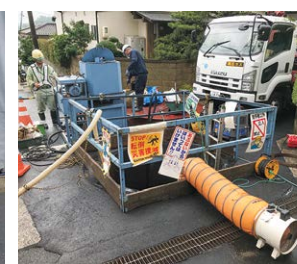
八木・緑井地区雨水管渠築造(その3)工事地下埋設物点検
