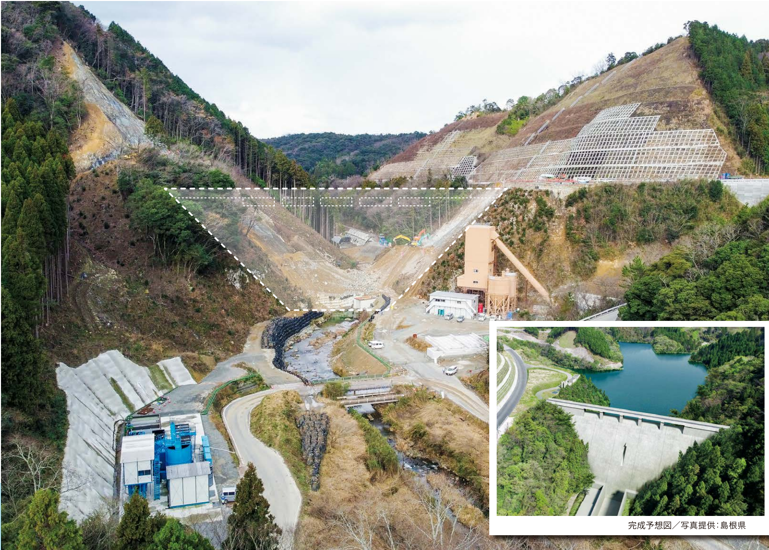
工事名：波積ダム建設事業 波積ダム本体建設工事 発注者：島根県 施工者：安藤・間・今岡工業・原工務所特別共同企業体 波積ダム（2020年2月現在）【上流から下流をのぞむ】 写真提供：島根県
