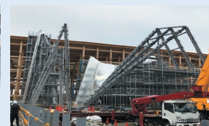
鉄骨建方の状況
