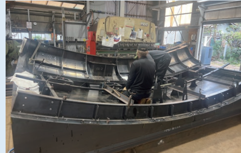
PC鋼製型枠
