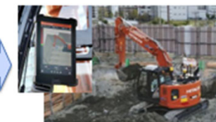
ICT建機による掘削
