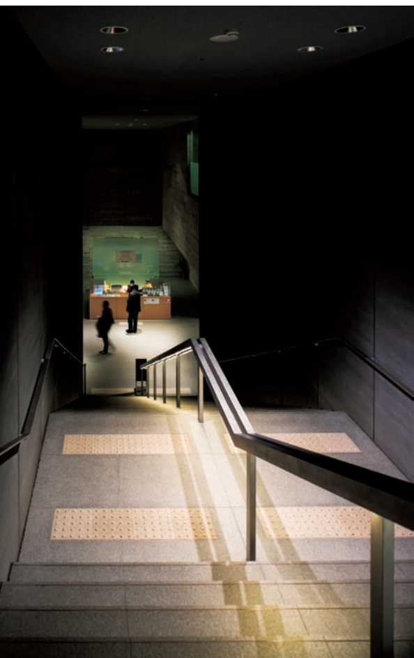
入口から地下2階まで階段がまっすぐに降りていく。奥深く、精神性を宿す空間を予感させる。壁面は杉板本実型枠によるコンクリート打ち放しと、アルミキャスト。
