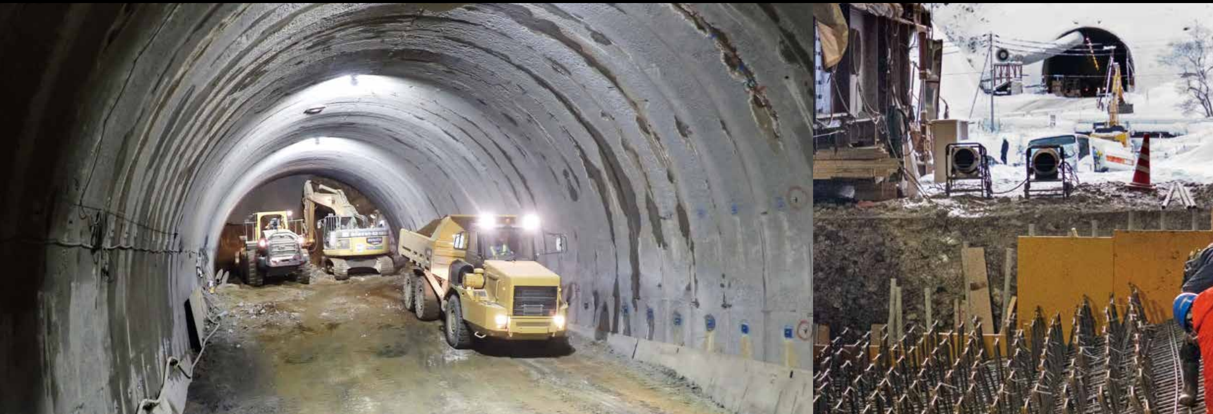
幌内トンネルではインパットの取付けと吹付けが行われている。貫通まではあと160m(1月取材時点)。貫通は3月中旬を予定。(提供:青木あすなろ建設株)
