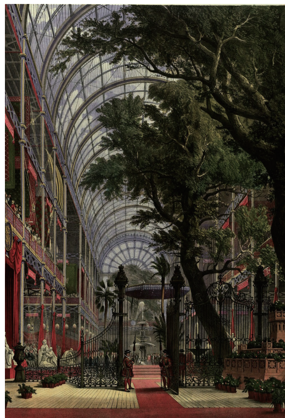
1851年のロンドン万博で建設されたクリスタルパレスの内部。ガラスのヴォールト屋根が架けられ、大木が館内に取り込まれている
