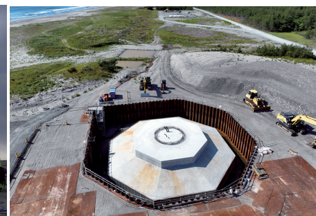
風車基礎完成
