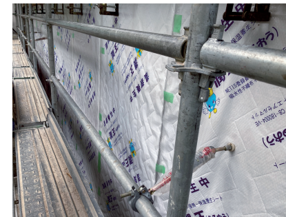
〔写真-2〕湿潤・保温シート
