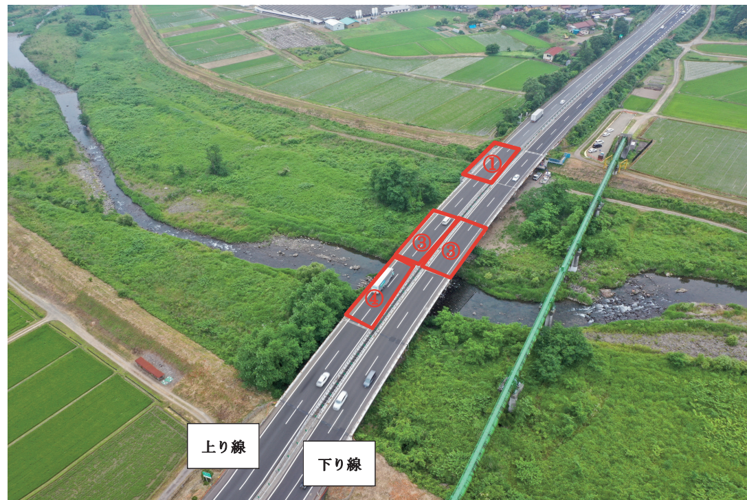
写真 1: 宮城松川橋 上空写真 (赤枠内: 施工範囲)
