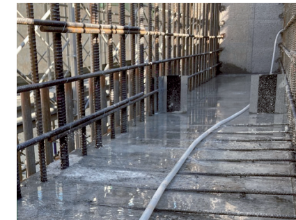
〔写真-3〕自動給水装置
