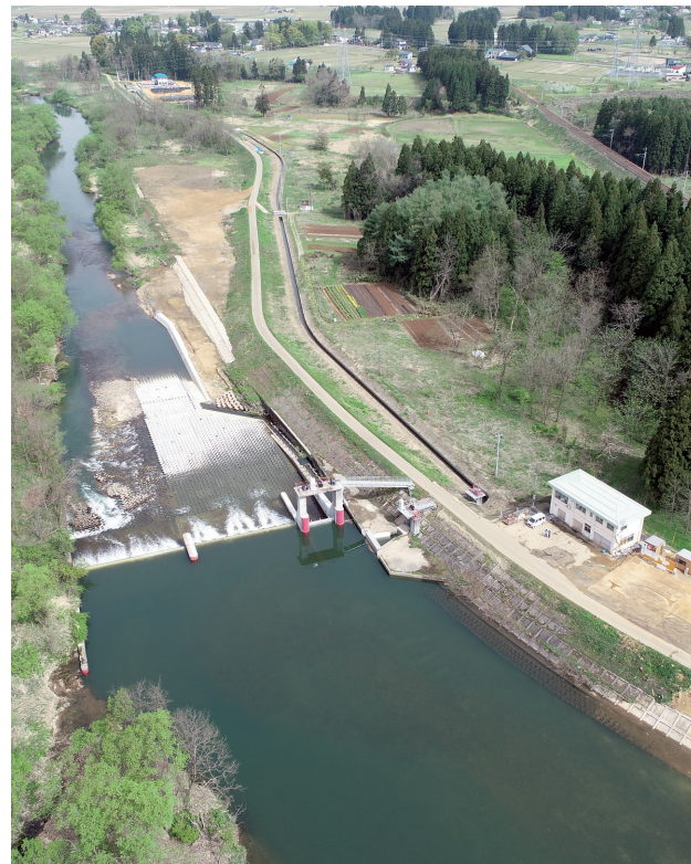
施工状況全景（2024/4/26）
