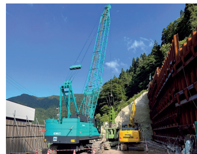
場所打杭掘削状況
