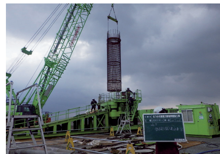
杭鉄筋建て込み状況
