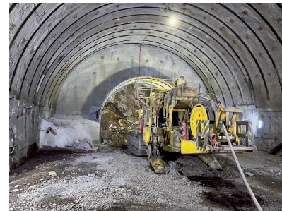
先進導坑掘削状況
