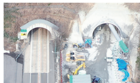
新旧トンネル坑口写真（離隔は約20m）
