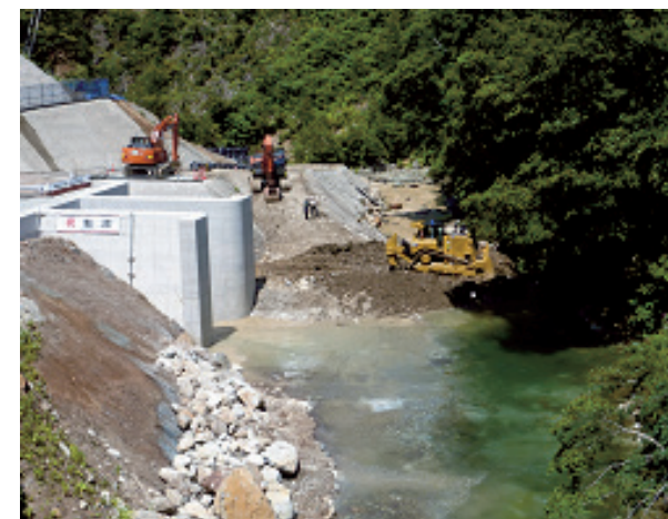
写真・1 堤外仮排水トンネルへの転流状況
