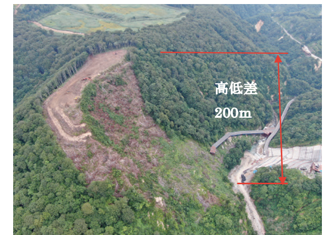
写真・2 右岸側堤体基礎掘削箇所
