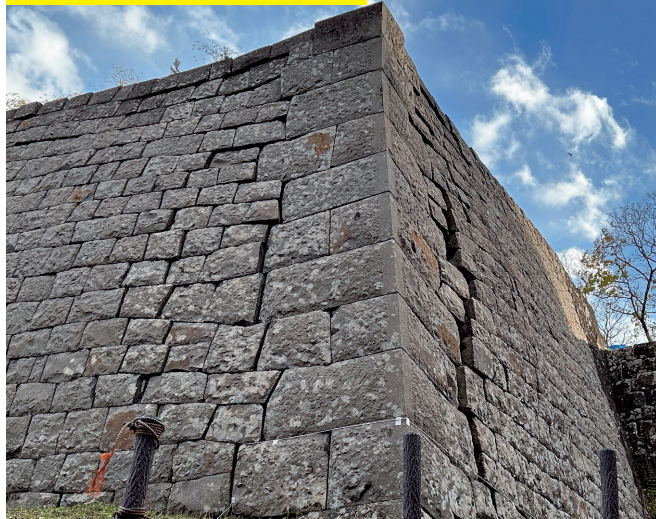
写真-1 福島県沖地震（2022 年 3 月）での被災状況
