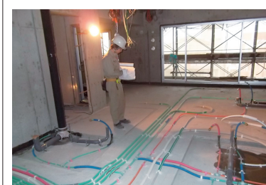
配管と施工図の整合を確認しています。床が出来る前に行います。
