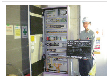
設備機器類を制御する盤の検査を実施中！
