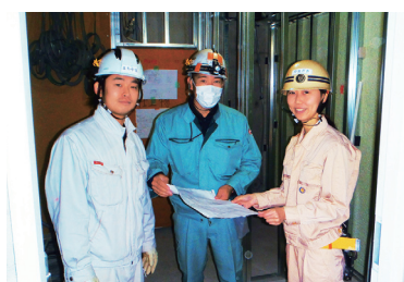
施工図通りにできているか 現場確認中！
