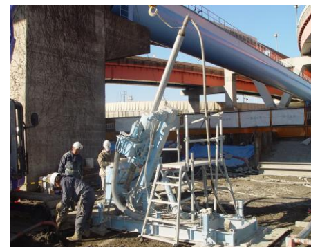
綾瀬川水管橋耐震補強工事 (東京都足立区)
