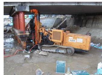
写真-2 施工状況
