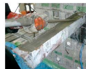
孔内へのグラウト材の充填
