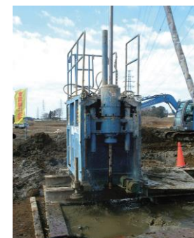
S型施工機
