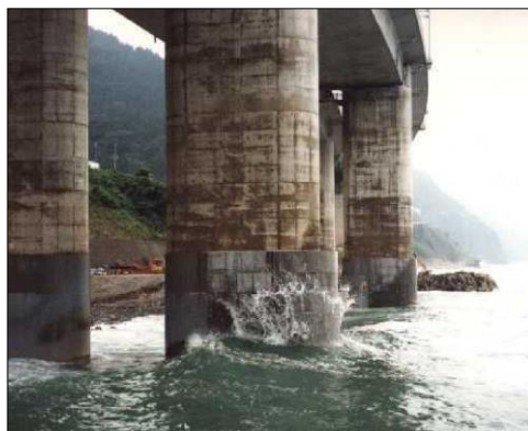
〔 橋梁下部工の波浪による塩害・磨耗対策 〕 波浪の厳しい橋梁下部工に於いての保全工事
