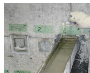
養生用の蓋の設置
