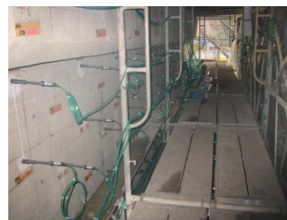
写真-2 抑制剤加圧注入状況
