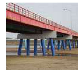
【斜杭の施工例】
