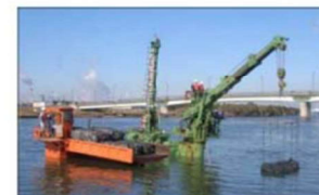
・籠運搬・据付工:千葉県市原市養老川
