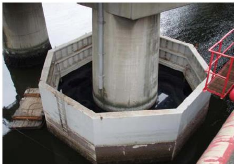
適用例：鉄道橋橋脚の補修工事（橋脚4基を対象）φ(下端)4.9m×h7.7m
