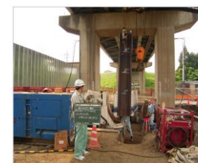
桁下での鋼矢板打設
