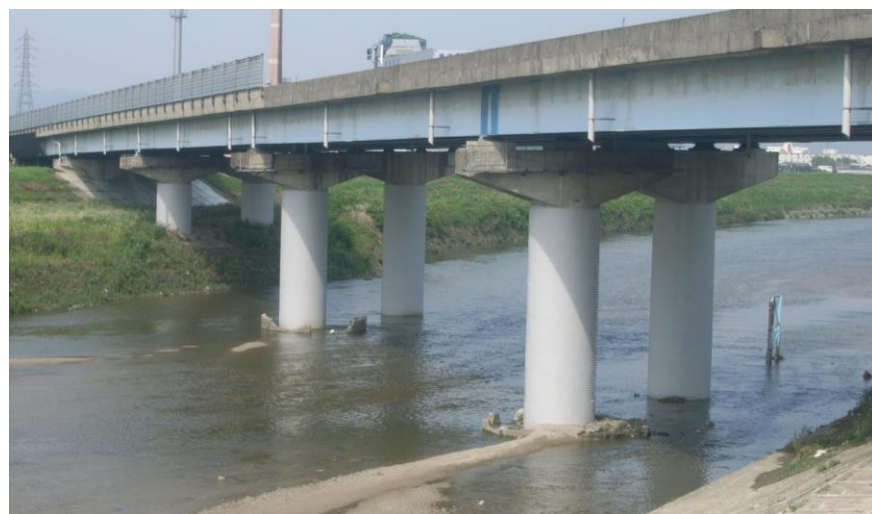
御幸大橋施工完了写真
