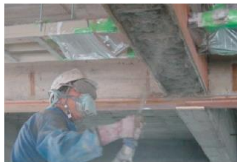
施工状況 Upward Spraying
