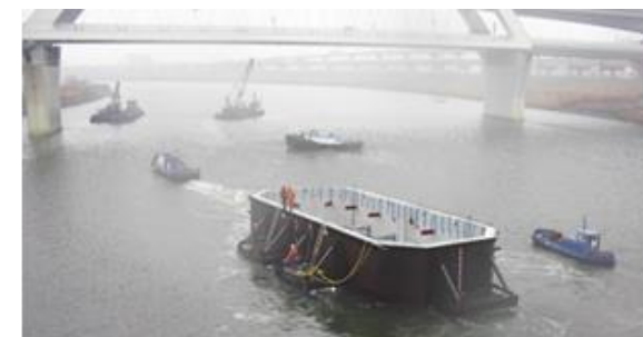
鋼製函体の現地への曳航状況
