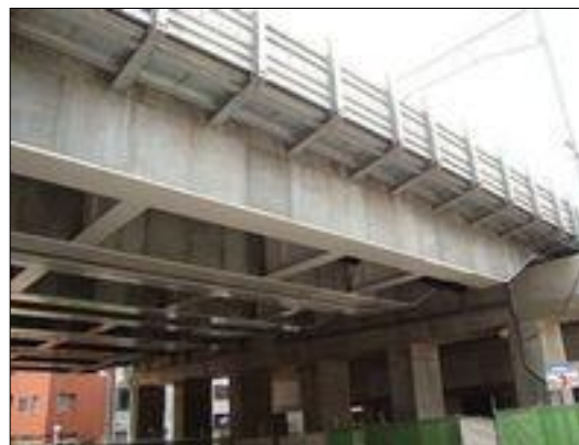
〔 鉄道本設利用工事桁 〕 高架下道路の拡幅に伴う線路桁(SRC 造)の架け替え工事用工事桁。 高架下道路は交通量が多く、線路についても主要な営業線で列車通過時の大きな振動が頻繁に発生する為、PIC フォームは桁の鉄骨に取り付け、支保工を必要としない構造とし、振動に配慮した目地を採用
