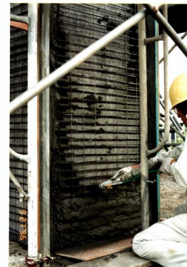
モルタルの吹付け
