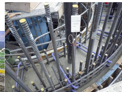
コンクリート充填状況
