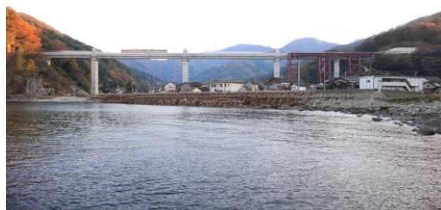
既設鉄橋隣での張出し施工状況
