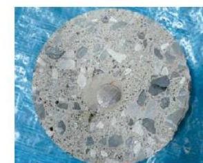
グラウト材の充填状況
