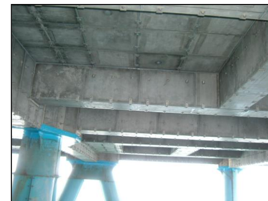
〔 海上栈橋の改修工事 工期短縮・塩害対策 〕 栈橋の改修工事。脱型を必要としないので、工期を短縮することが可能。また、将来のメンテナンスを軽減できる
