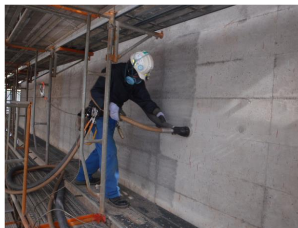
写真-1 施工状況
