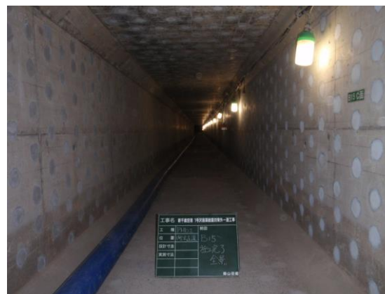
国土交通省北海道開発局 新千歳空港1号涵渠耐震対策工事
