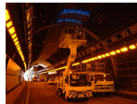
〈中央自動車道小仏トンネル集中工事施工状況〉
