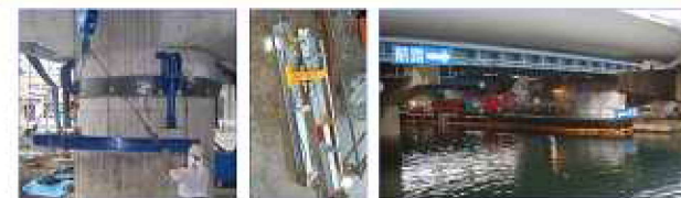
分割・小型化された専用の圧入装置、WJ剛孔装置
