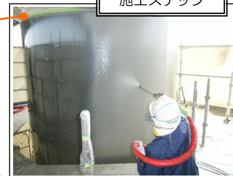
STEP3 UUライニング吹付け状況
