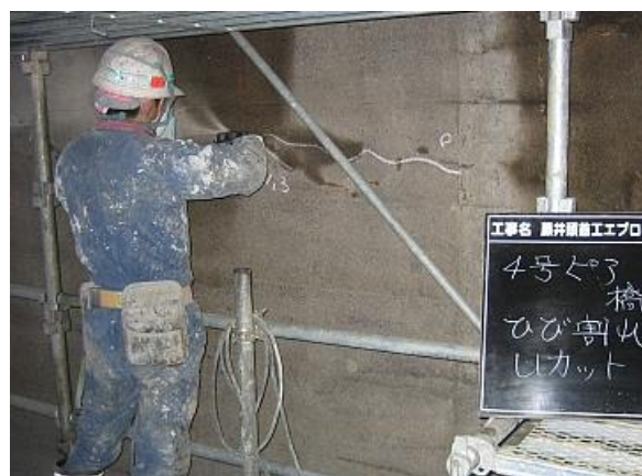
ADOX システムによるひび割れ注入状況
