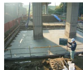
増設フーチング完了
