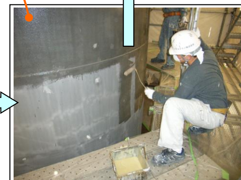
STEP2 ライマー塗布状況
