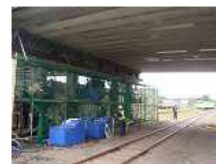
【跨線橋の施工例】
