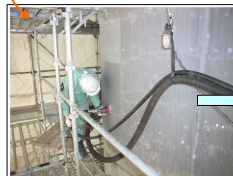
STEP1 下地処理（ブラスト）状況
