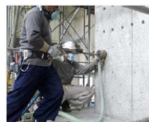
レッグハンマーによる削孔
