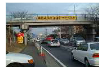
【跨道橋の施工例】
