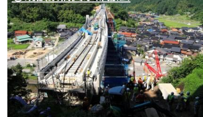
②既設鉄橋支承部撤去
