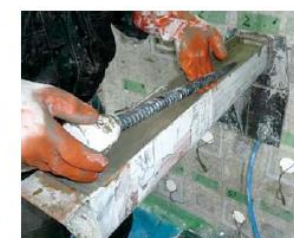
セラミックキャップバーの挿入
