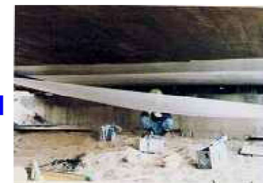
【補強布張り・中塗り】
