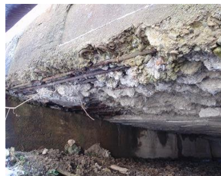
写真4 橋梁床版状況
