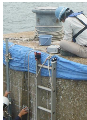
図-2 鉄筋腐食診断状況
