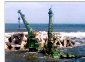
ブロック運搬・据付工：福島県南相馬市村上海岸
