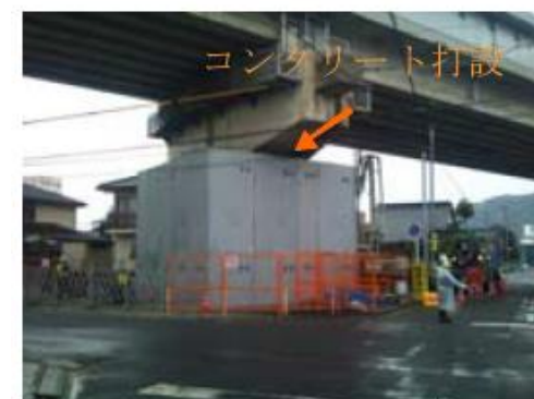
耐震補強橋脚
