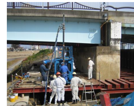
昭栄大橋左岸橋脚補強工事 (新潟県三条市)
