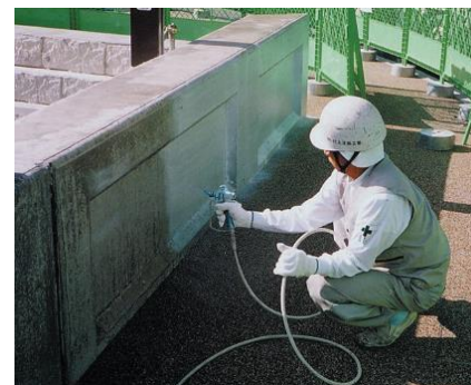
塗布状況（エアレススプレー）
