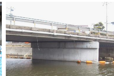
写真-2 施工完了
