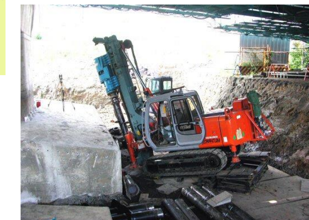
施工状況写真
