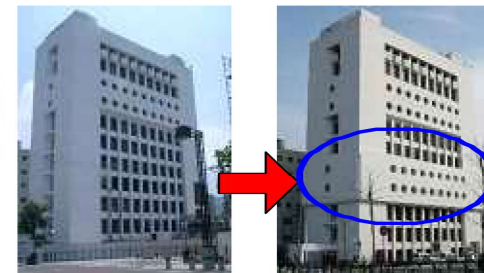
【耐震壁の設置】
