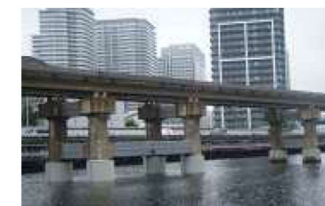
【鉄道橋の施工例】
