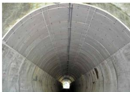
(道路トンネル)
