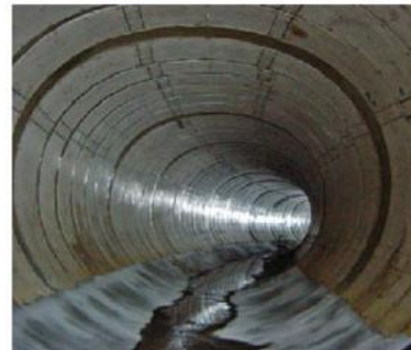
(水路トンネル)
