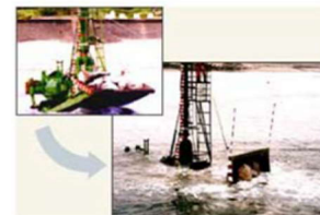
捨石運搬・敷設工：千葉県銚子君ヶ浜
