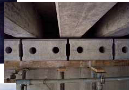
【拡幅部（プレキャストブロック）設置】
