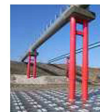
【水管橋の施工例】
