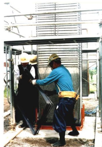
スパイラル鉄筋の装着
