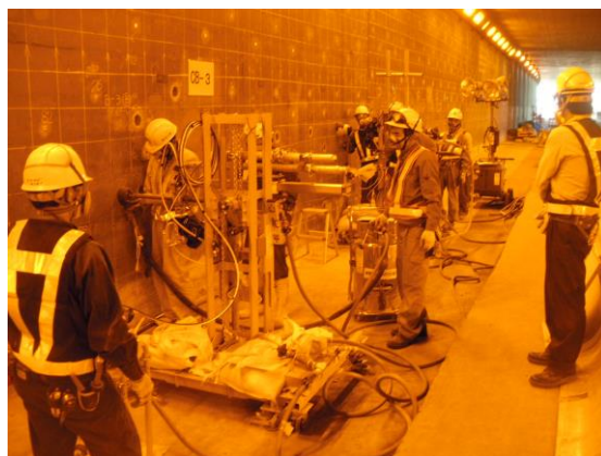
国土交通省北海道開発局 新千歳空港地下道耐震対策工事
