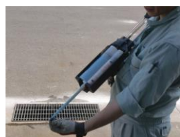
トータツエポキシ充填
