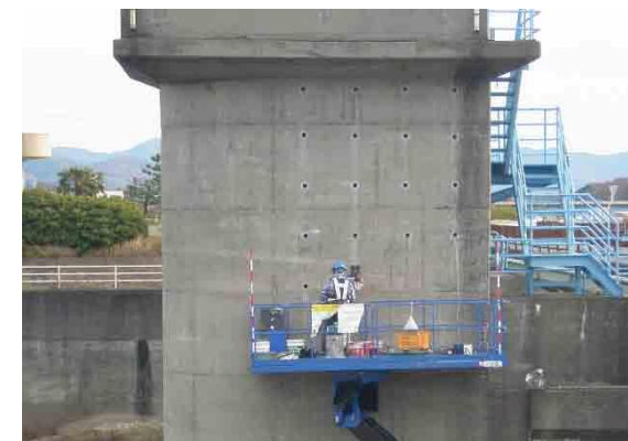
国土交通省中部地方建設局 豊川放水路分流堰耐震対策工事
