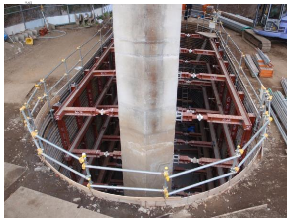
写真-1 土留め設置完了（スルーサー設置）
