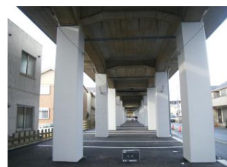
ラーメン高架橋
