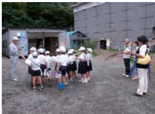
旧増田家住宅復原修理の現場公開
